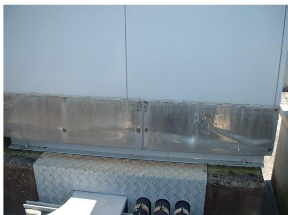
写真－4 ボックスの鉄板による補修
