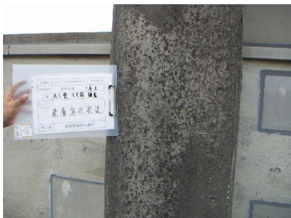
写真-1 RC柱風化
